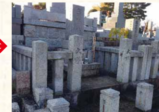
【外柵】親柱・角柱・小柱 再建立完成
